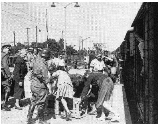
na stacji Włochy
