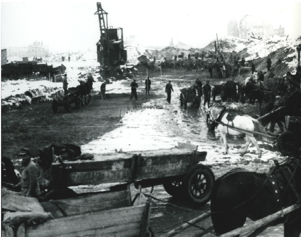
Rozpoczęto mechaniczne wywożenie gruzów...
