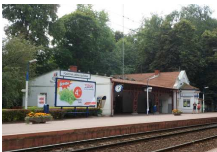
stacja EKD w Podkowie Leśnej
