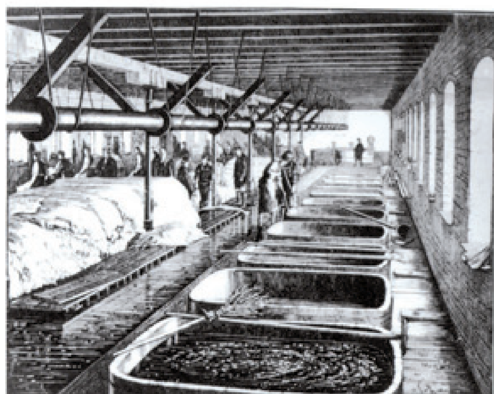
Wnętrze hali z kadziami do moczenia skór w garbarni braci Temlerów i Szwedego w Warszawie, 1873 (APW) ◆ Interior of the hall with vats for soaking leather in the brothers Temler and Szwed tannery, 1873 (APW)
