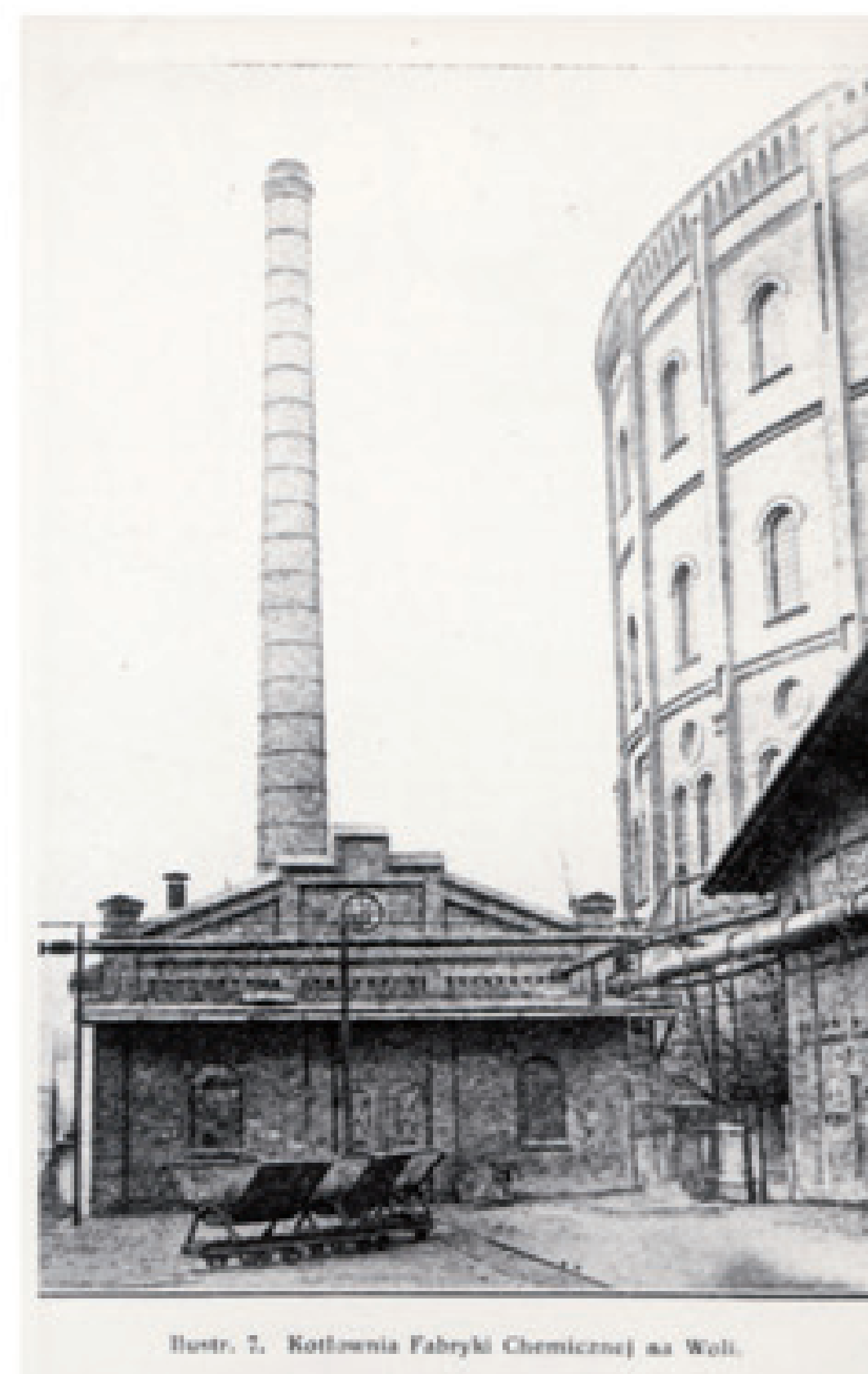
Kotłownia Fabryki Chemicznej na Woli, przy ulicy Dworskiej 25, 1926 (APW) ◆ Boiler-house of the Chemical Factory in Wola, Dworska Street 25, 1926 (APW)
